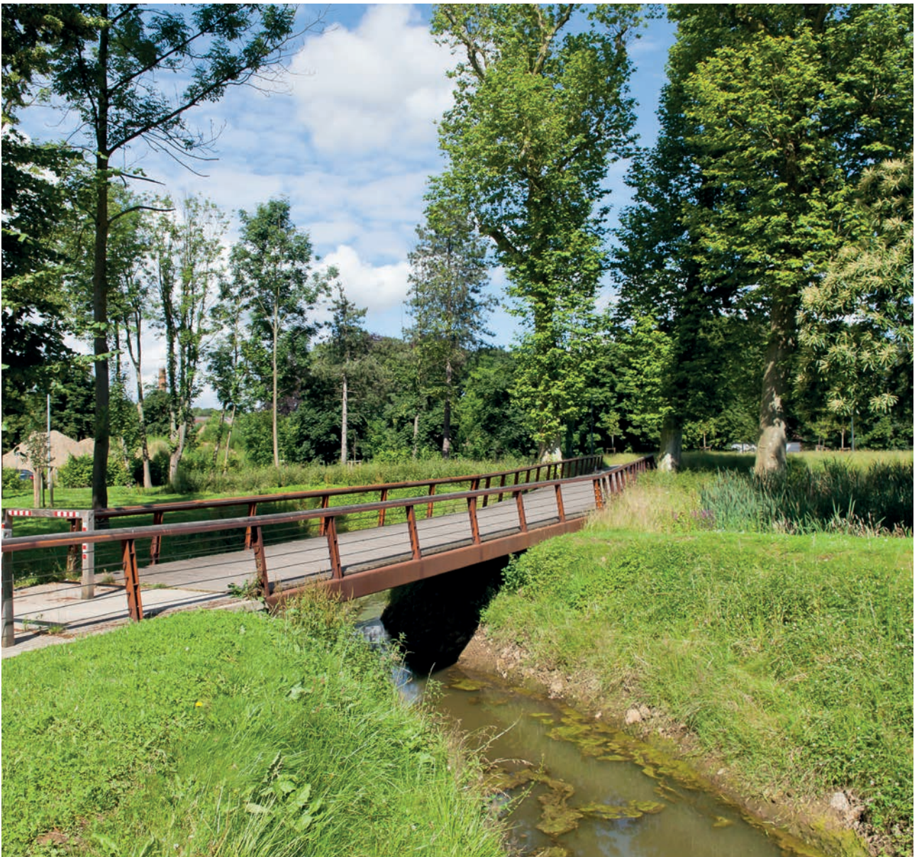
Ook de nieuwe brug aan het ziekenhuis werd afgewerkt met cortenstaal.
